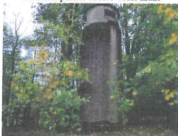
Bývalý vodojem na pozemku parc.č. 1865/3
