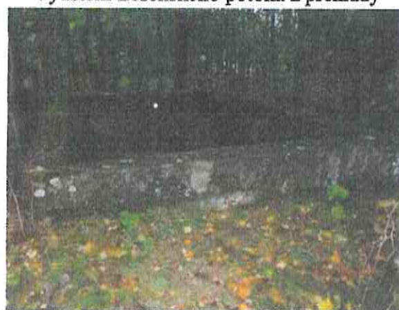
Šachta pro bývalou turbínu na odvrácené straně hráze (mimo oceňované pozemky)
