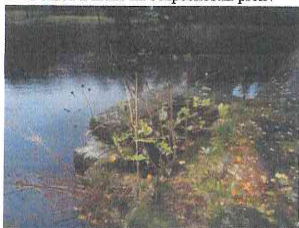
Požerák u hráze
