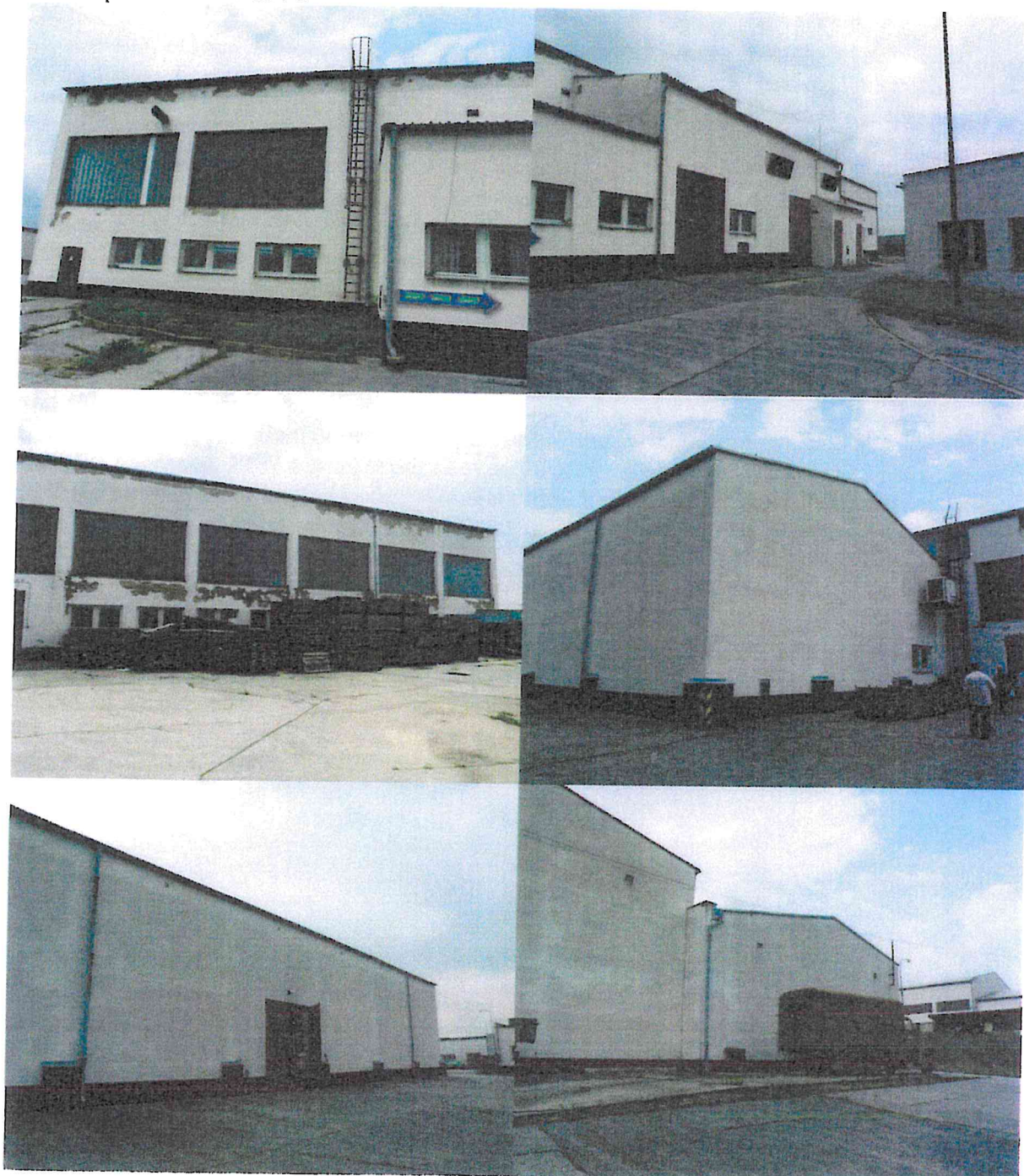
Obr. č. 2-7: sklad vína s kotelnou na stp. 293
