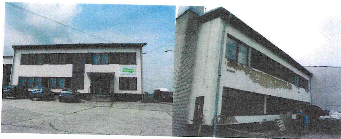
Obr. č. 10-11: administrativní část budovy s kotelnou na stp. 496
