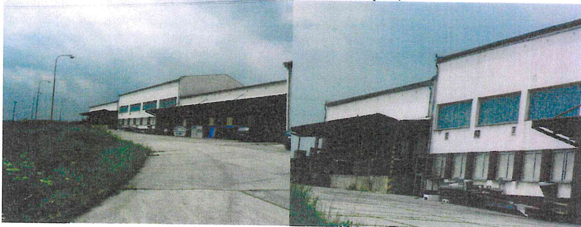
Obr. č. 8-9: skladové prostory budovy na stp. 495
