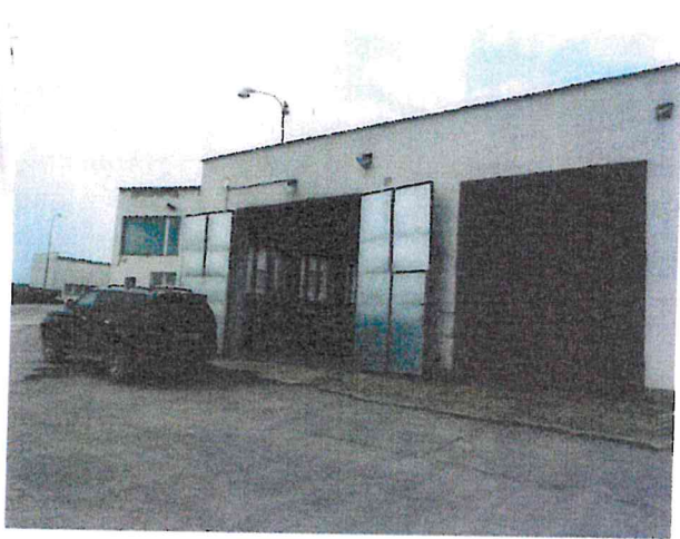
Obr. č. 12-15 – objekt údržbářské dílny
