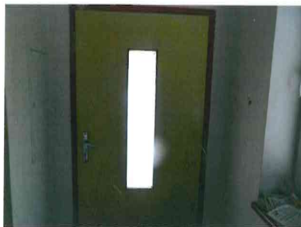
Vstupní dveře do objektu
