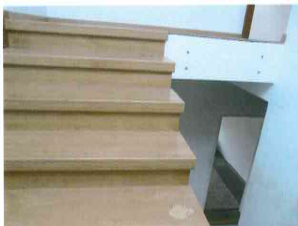
Schodiště do 2. NP s odstraněným zábradlím
