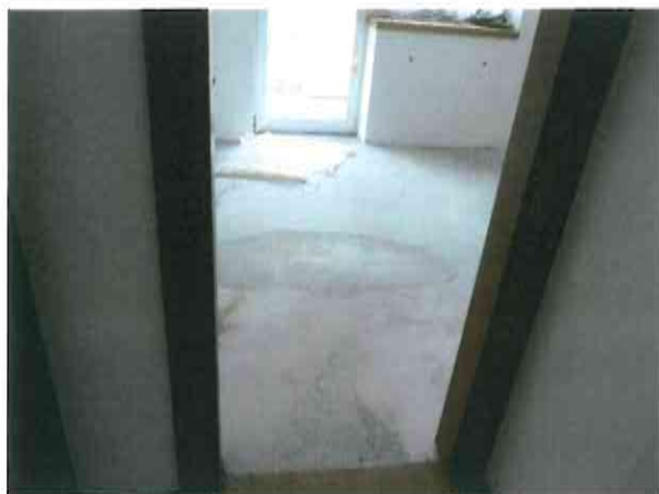
Pokoj č. 2 (2. NP) se vstupem na lodžii
