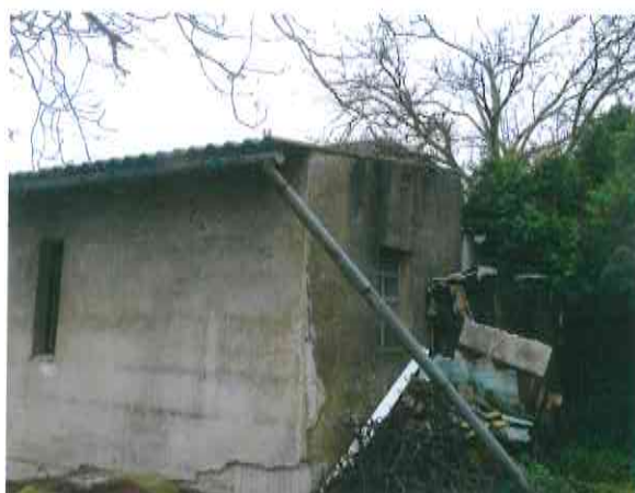
Garáž na stp. 214 – pohled ze zahrady
