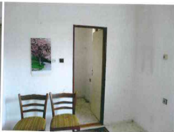
Vstup do komory (spíže) za kuchyní (1. NP)
