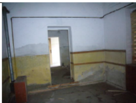
interier administratívnej budovy – I. NP
