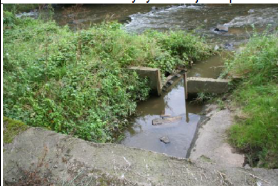
Výpust' a vývařístě s hrazením
