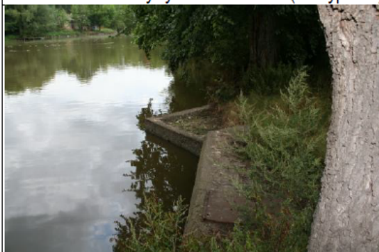
Pohled na hladinu od přepadu
