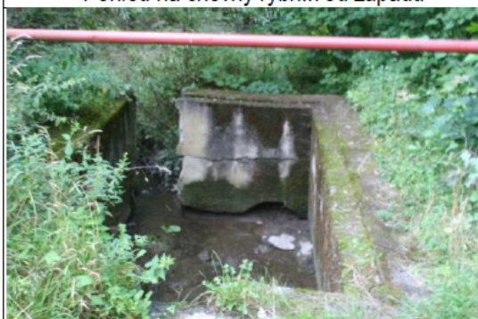
Objekty rybníka jsou v havarijním stavu
