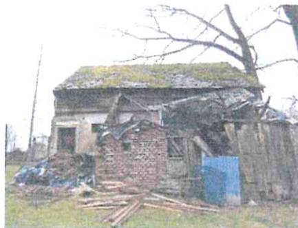
Pohled jižní- přístřešek
