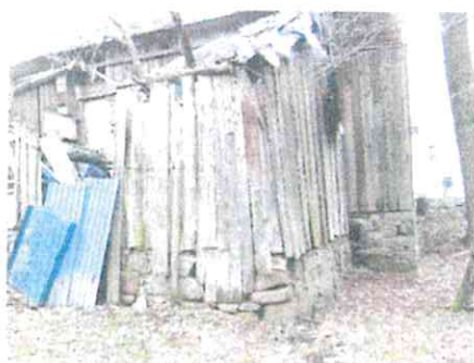
Pohled JV – přístřešek , sokl
