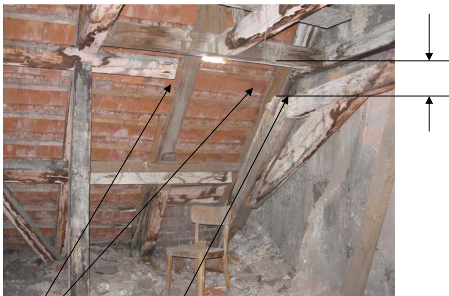
POKLES VAZBY - UHNILÁ SPODNÍ ČÁST VZPĚRY VYŘEZANÉ VAZNICE A PROVIZORNĚ PODEPŘENÉ
