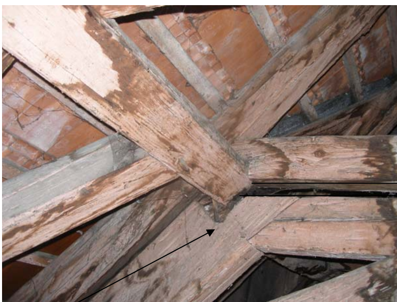
UVOLNĚNÝ SPOJ VZHLEDEM K POKLESU ZHORA UVEDENÉ VAZBY
