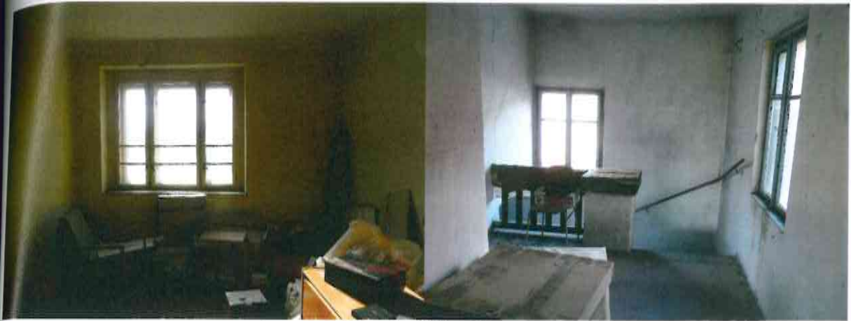
místnost v 2. NP, schodiště s přístupem na půdu
