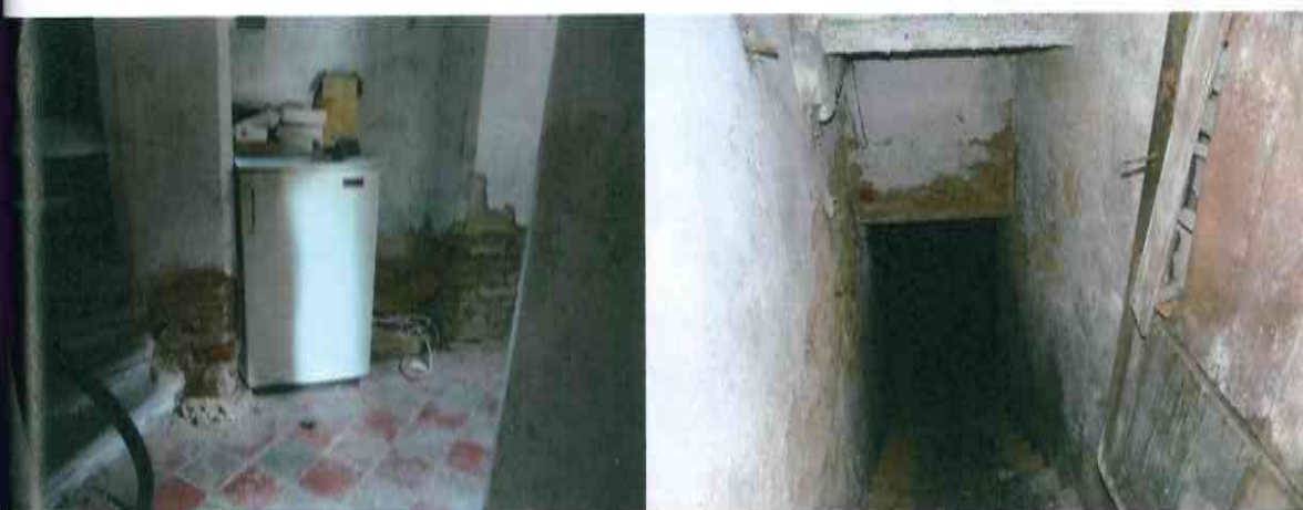
vstupní schody do 2. NP a do 1. PP
