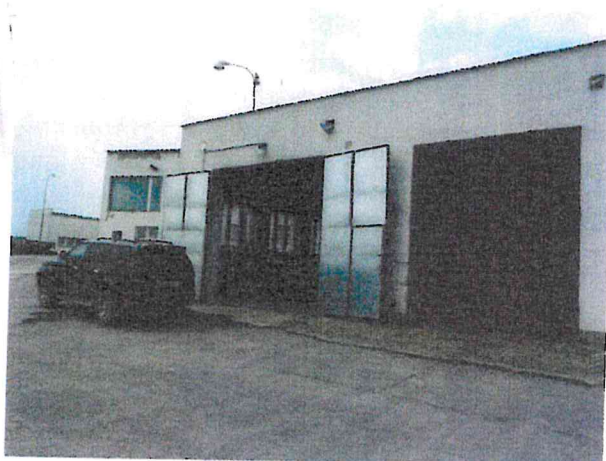
Obr. č. 12-15 – objekt údržbářské dílny
