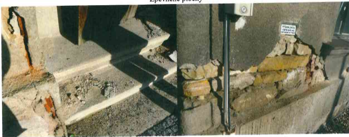
Vstup do RD
