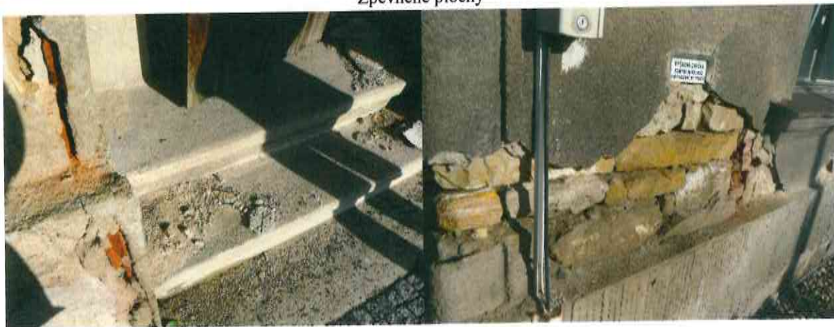
Vstup do RD
