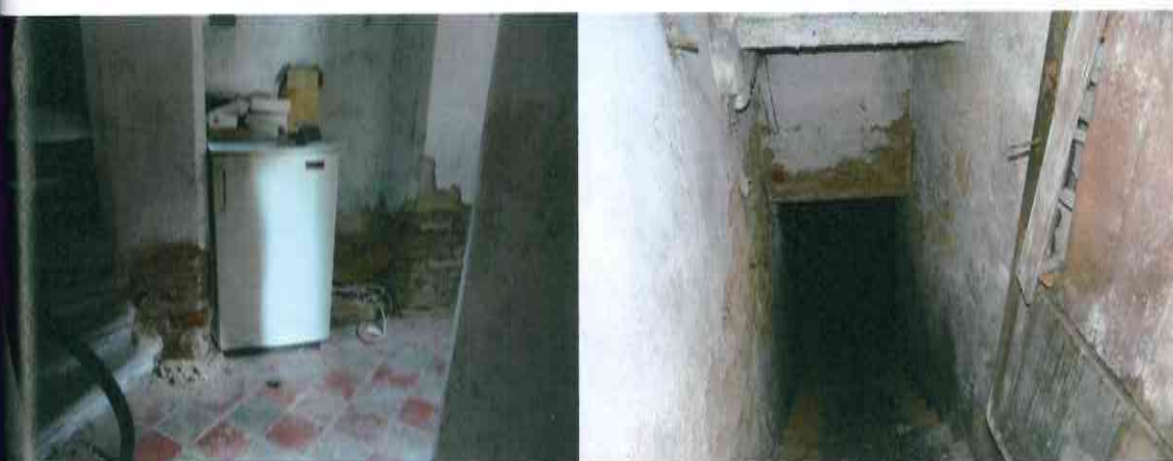
vstupní schody do 2. NP a do 1. PP
