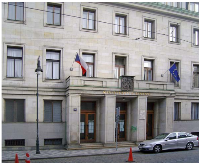
Главный вход в здание с улицы Летенска
