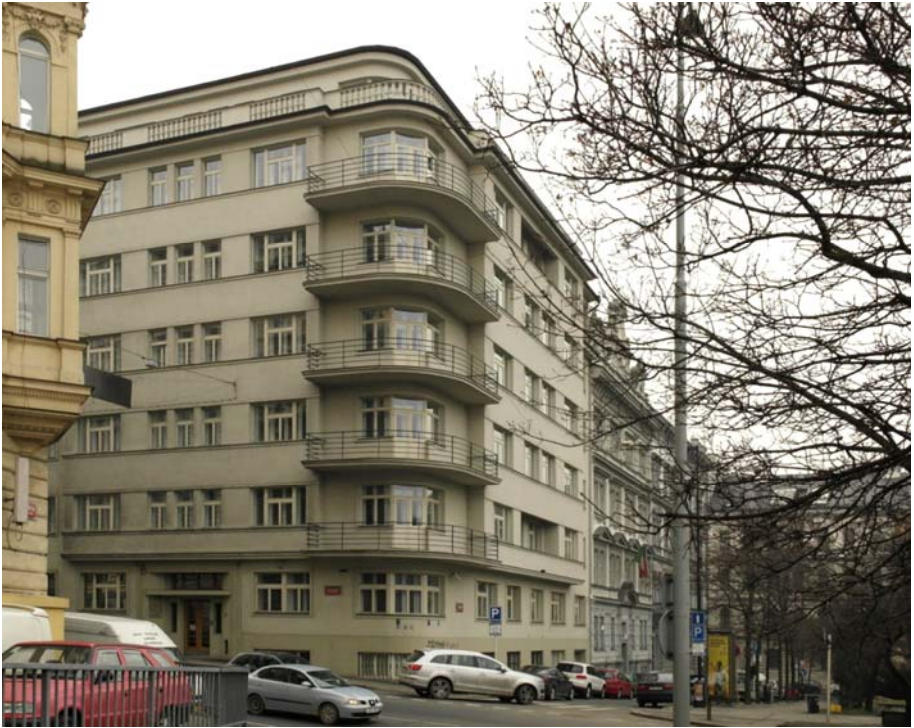
Das Gebäude heute
