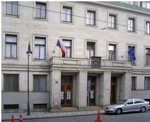
Haupteingang des Gebäudes in der Straße Letenská
