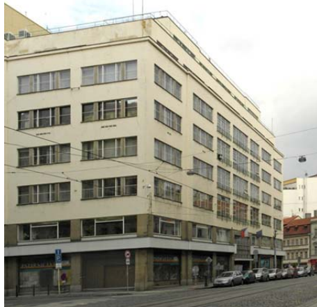
Das Gebäude heute
