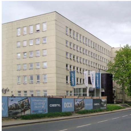
Das Gebäude heute
