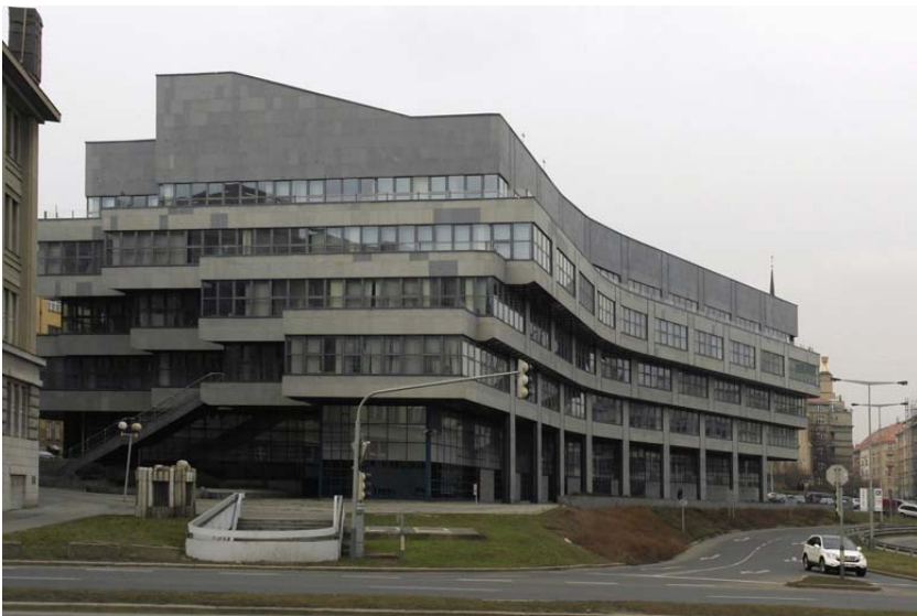
Das Gebäude heute
