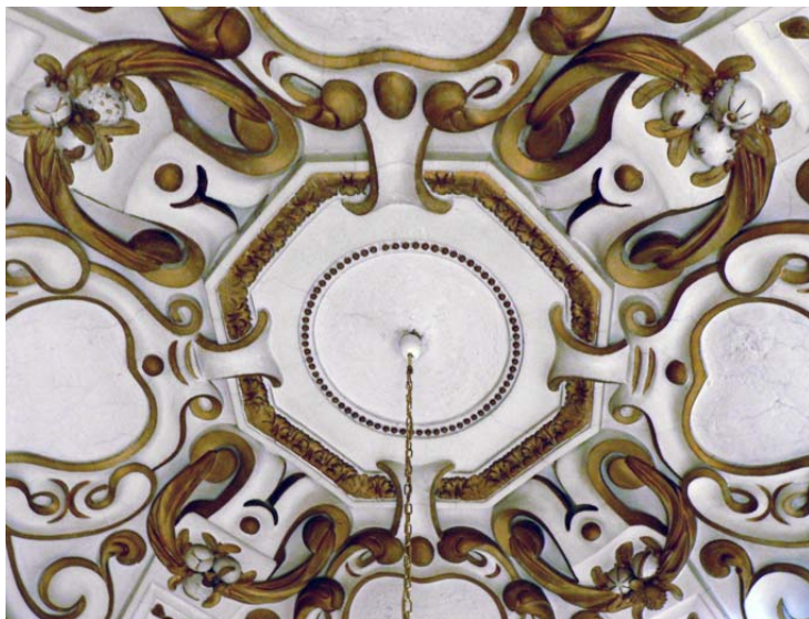
Štuková výzdoba neckově klenuté místnosti východního křídla
