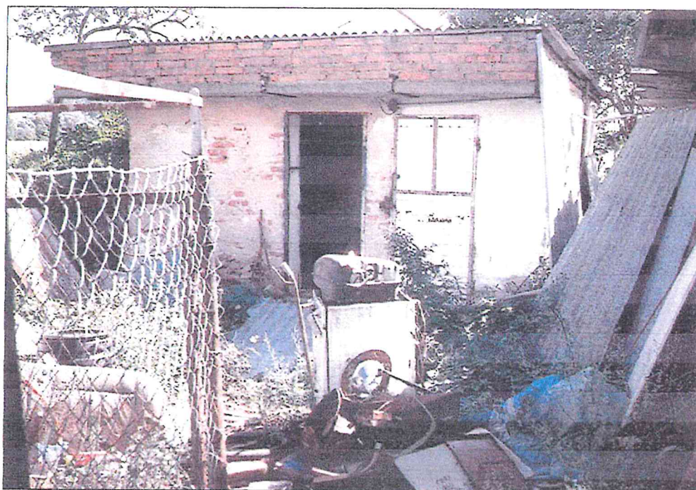
Obr. č. 4 – Zemní sklep
