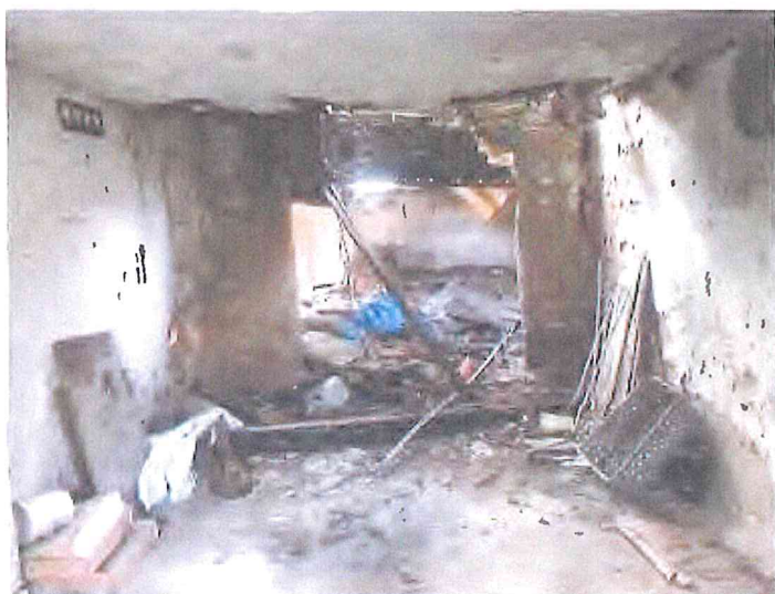
garáž na parc.č. 823/4
