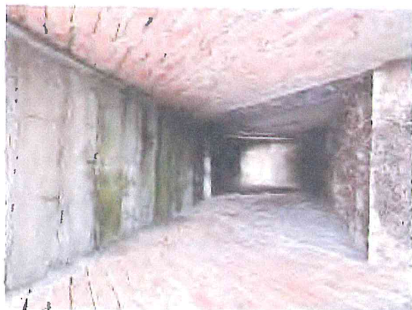
Zemní sklep na parc.č. 823/7
