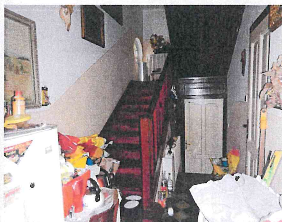
schodiště na půdu
