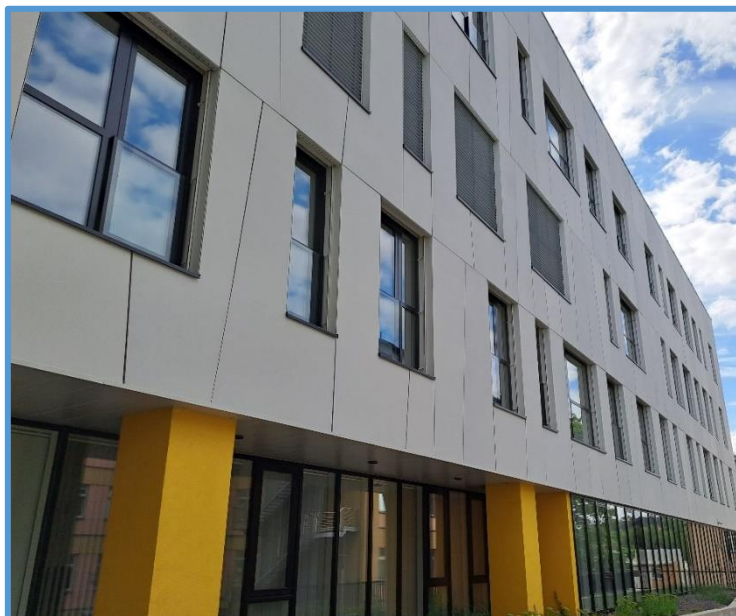
Obrázek 8: Nemocnice Pelhřimov – výstavba nových pavilonů v pasivním energetickém standardu (foto: Auditní orgán)
