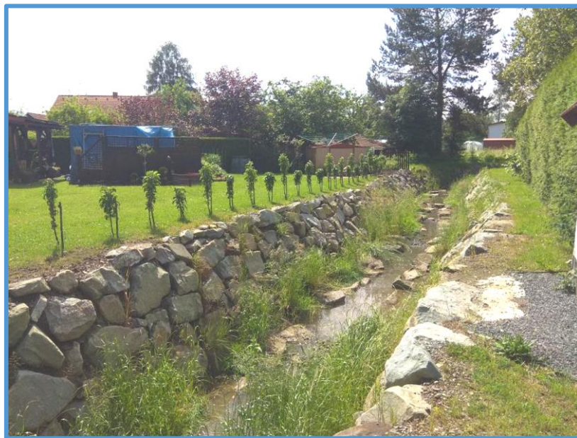
Obrázek 21: Realizace opatření k ochraně přírody a k adaptaci na klimatickou změnu- lesní potok Ondřejnice (foto: Auditní orgán)
