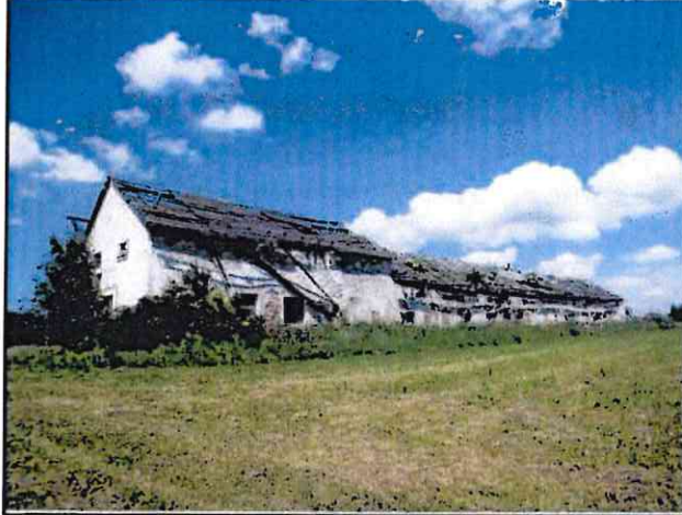
Pozemek p.č. St. 33 včetně objektu - pohled jihovýchodní
