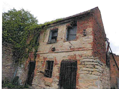
st.93 – stavba bez čp/če pohled jižní
