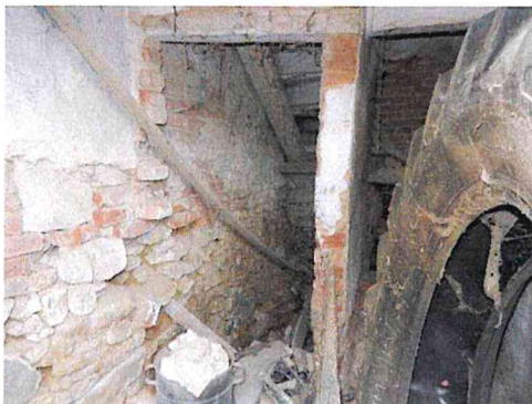
Stavba bez čp/če- interier
