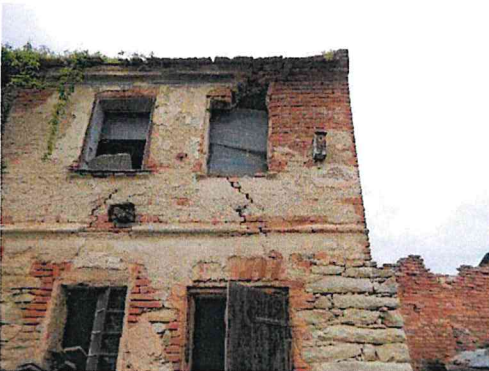
St. 93 – stavba bez čp/če- pohled jižní
