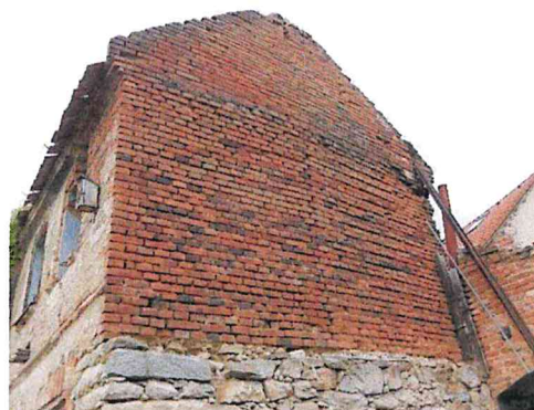
st. 93 – stavba -pohled štít východní
