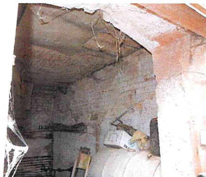
Stavba bez čp/če – interier
