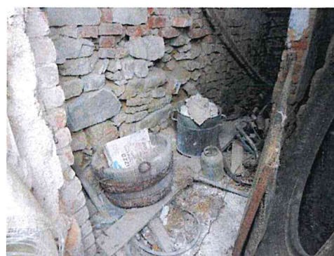
Stavba bez čp/če- interier
