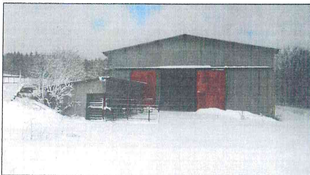
Foto č. 1 Uzavřený ocelový sklad a ocelový přístřešek 1 na pozemku St. 1
