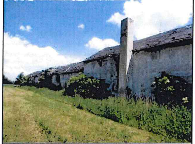
Pozemek p.č. St. 33 včetně objektu - pohled jihozápadní
