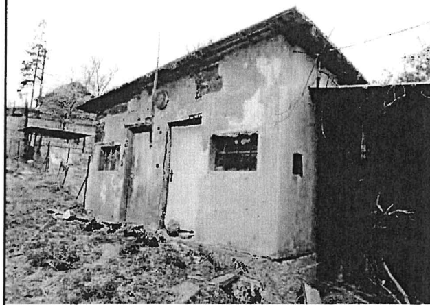
Pouze objekt bez čp/če, na pozemku p.č. St. 216 - pohled JZ
