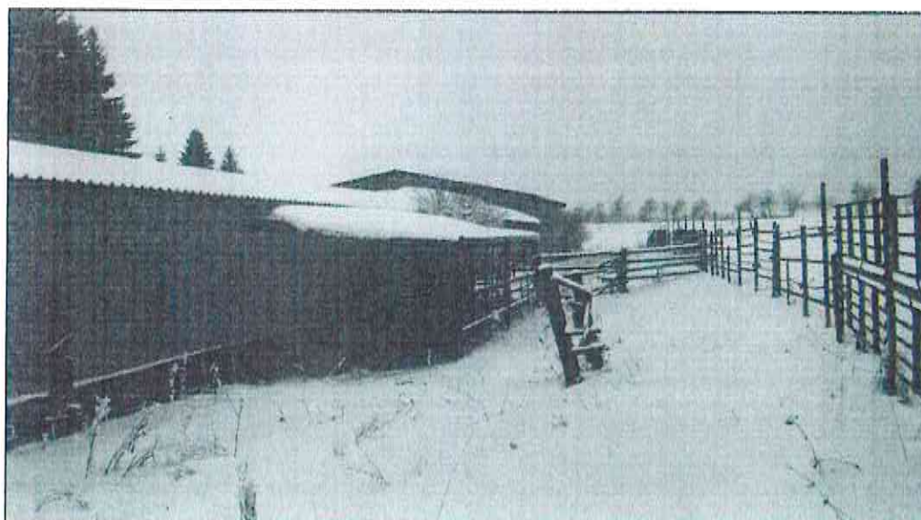
Foto č. 3 Otevřená ocelová hala na pozemku St. 1 a Ocelový přístřešek 2 + Ocelové ploty na pozemku parc. č. 152/2
