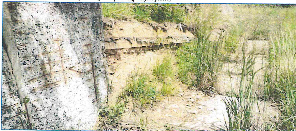
F 7: Detail S části se zříceným okrajem a polorozpadlými panely
