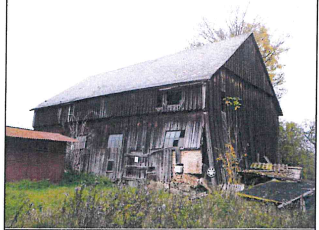
Pozemek p.č. St. 31/2 včetně stavby - pohled severozápadní
