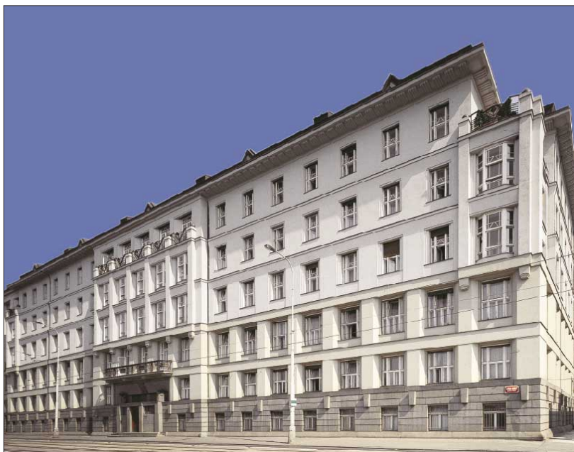
Budova Fondu národního majetku
