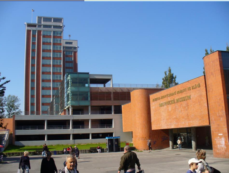
Garážový dům před budovou č. 21, r. 2013
