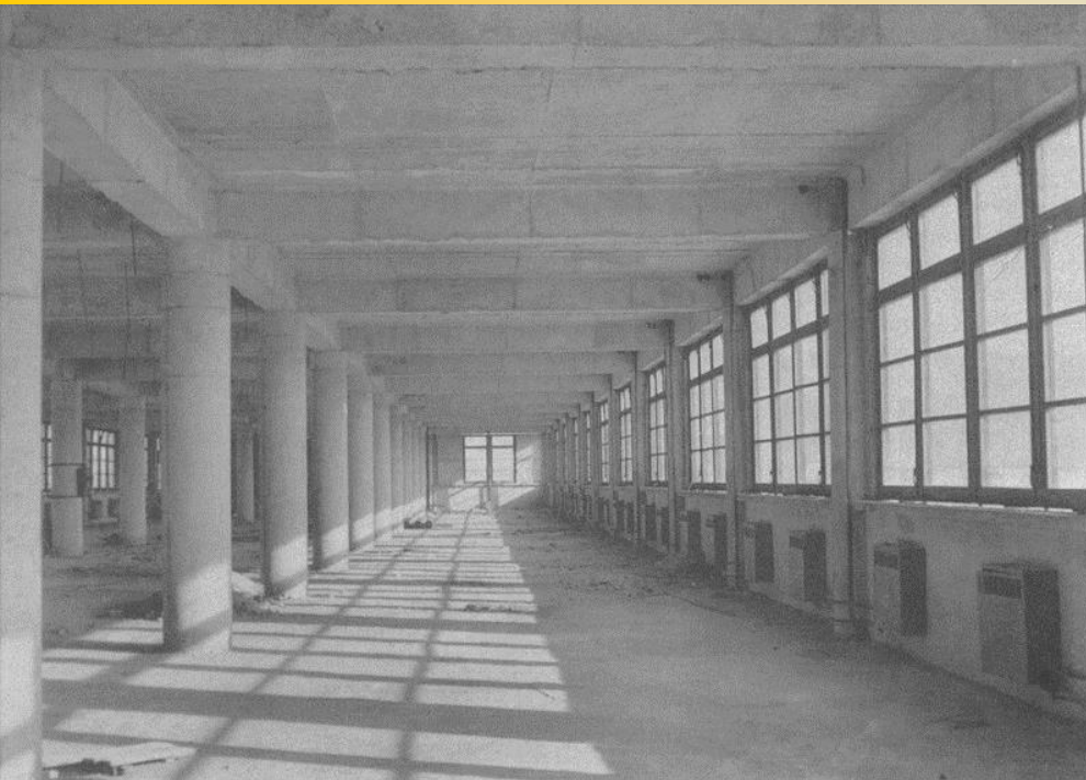
Vnitřní prostory tovární haly s konstrukčním polem
