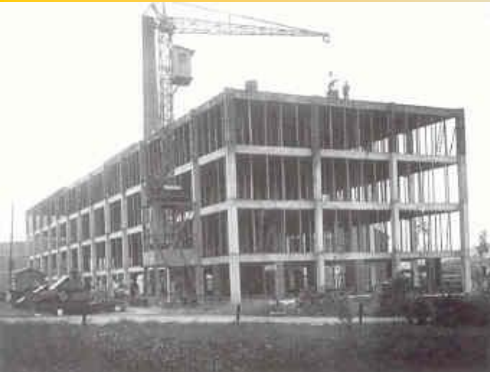
Výstavba továrního areálu
