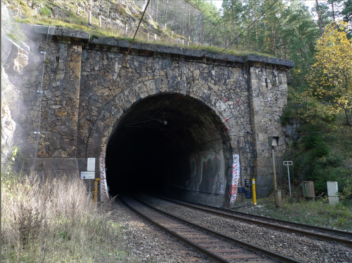
Semmering, tunel bývalé státní později Jižní dráhy, Kalte Rinne, 1884-1854, památka UNESCO od roku 1998
