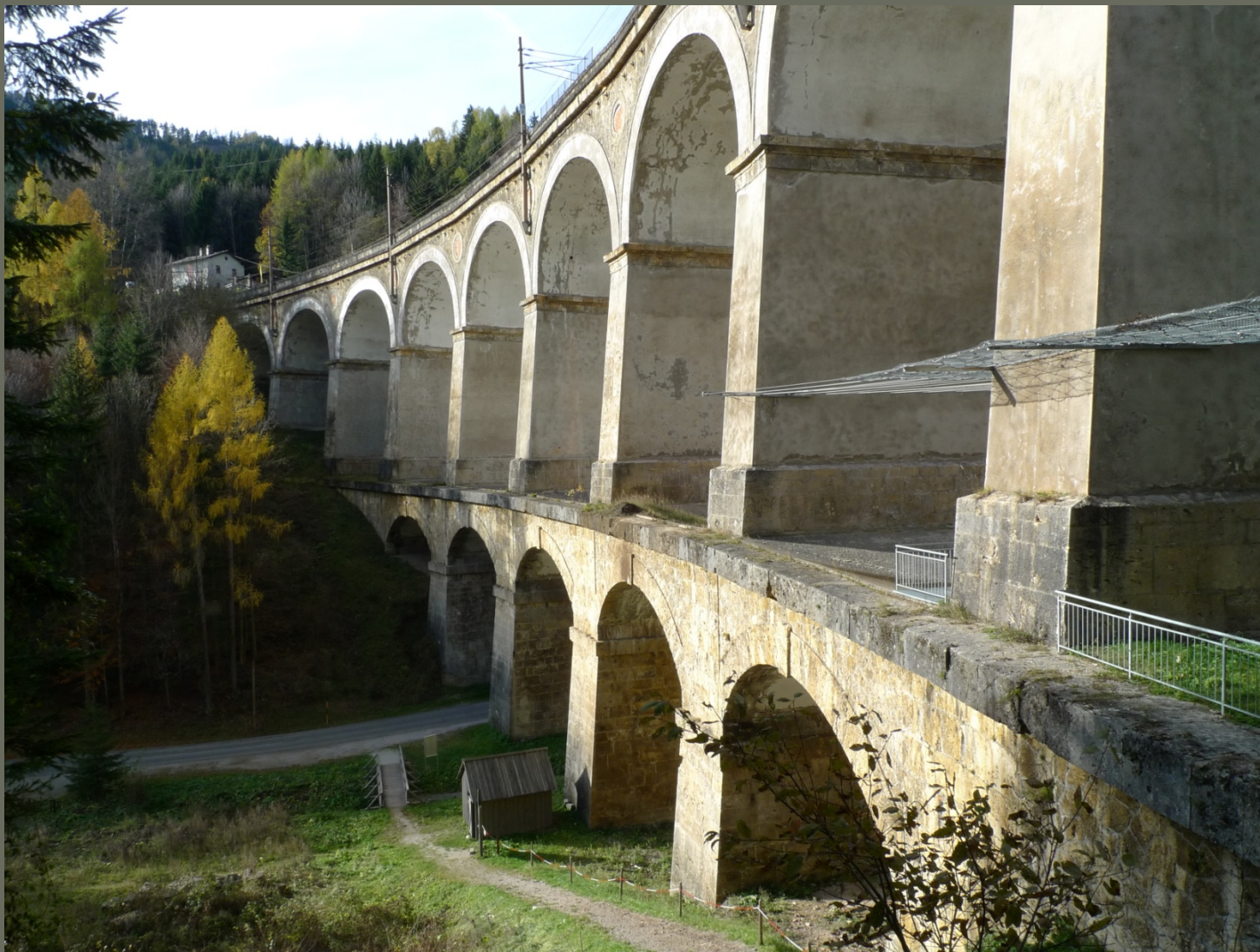
Semmering, viadukt bývalé státní později Jižní dráhy, Kalte Rinne, 1848 -1854, památka UNESCO od roku 1998
