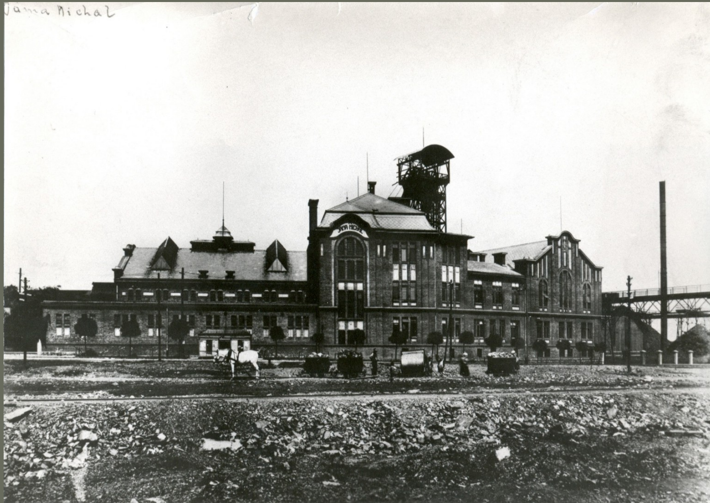
Michálkovice, důl Michal, později Petr Cingr, příklad reprezentativně pojaté architektury a moderních provozních zásad realizované v letech 1912- 1915
