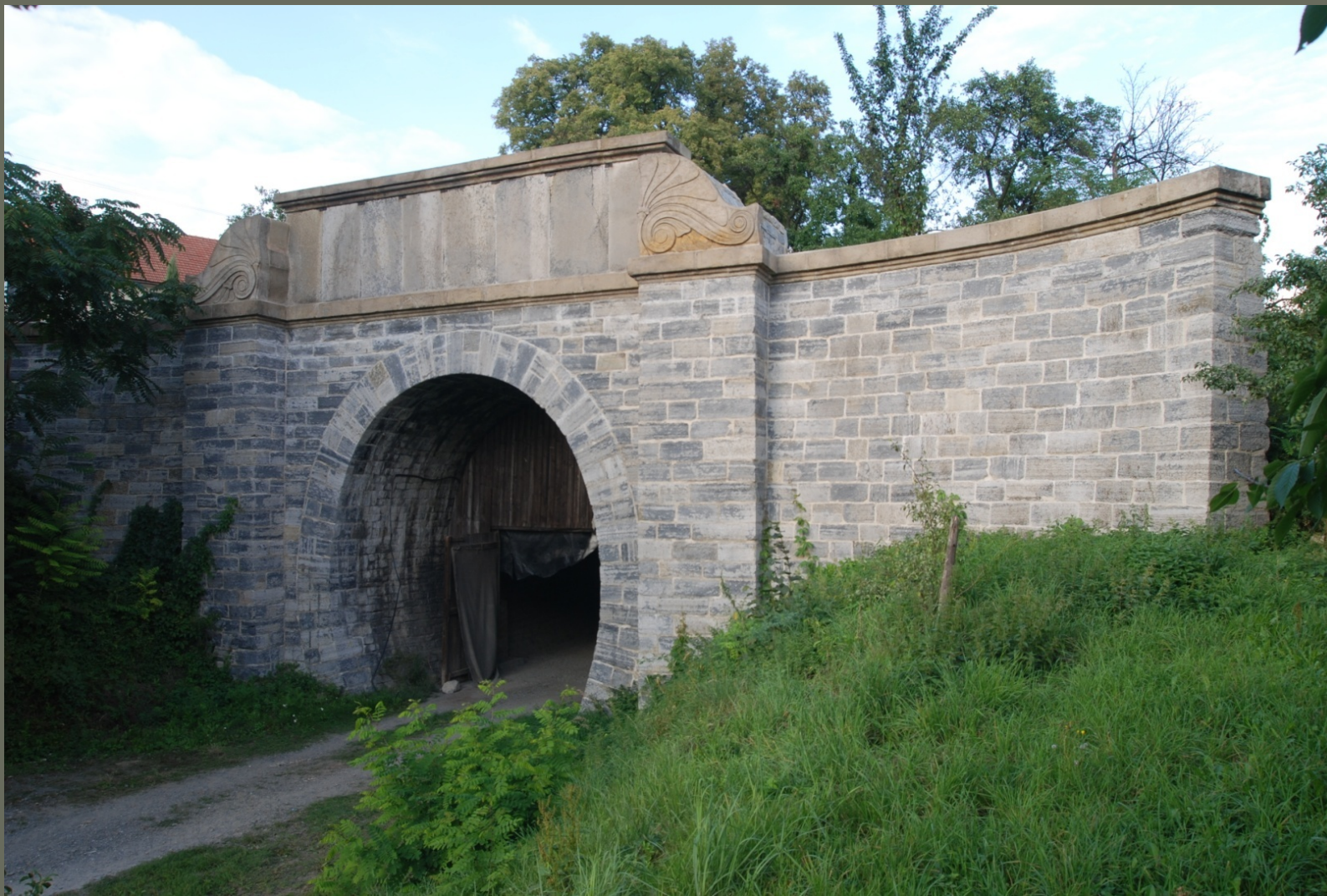
Slavič, tunel Severní dráhy Ferdinandovy, 1842 - 1845
