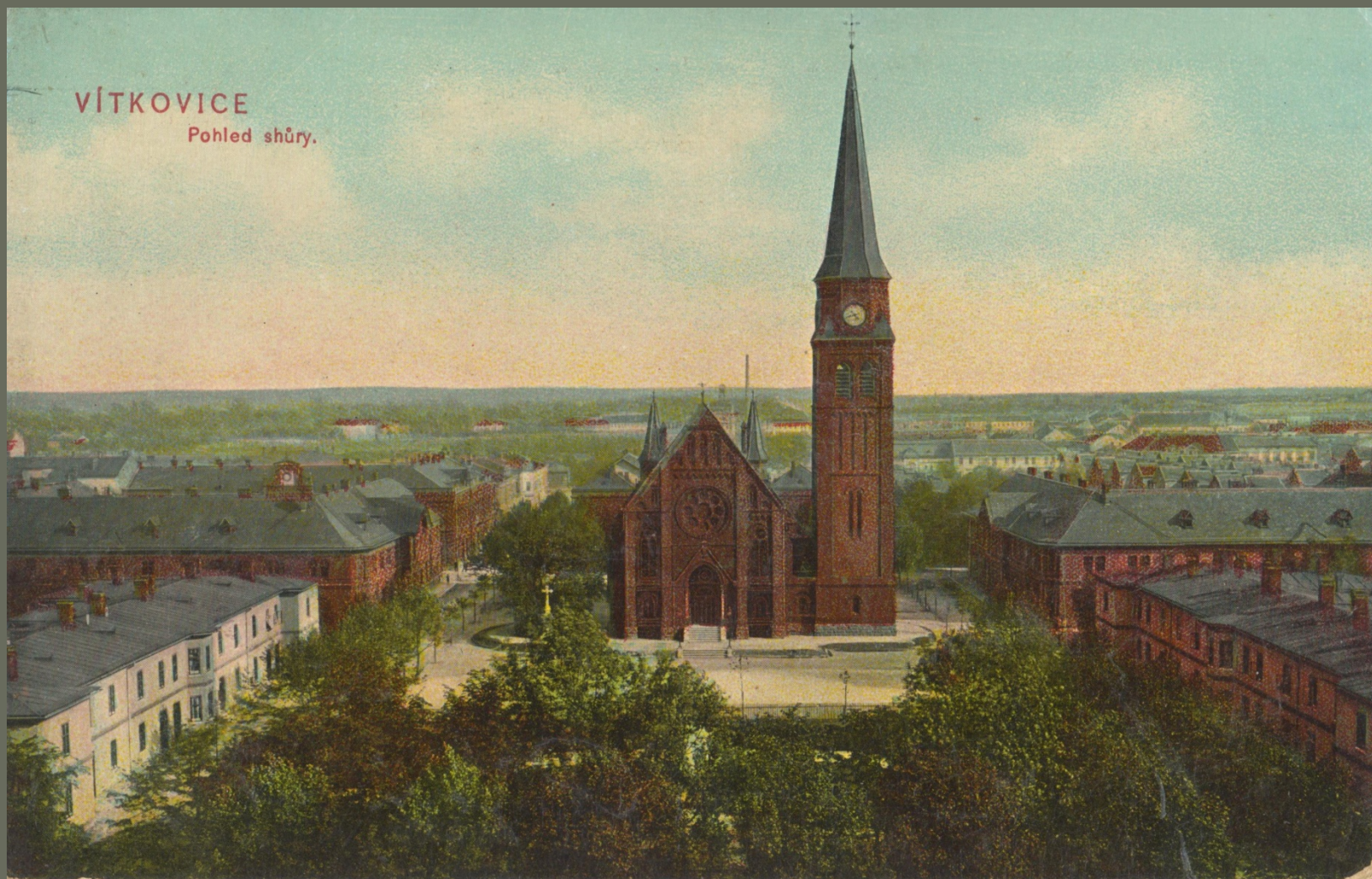
Vítkovice, kostel, architekt Augustin Kirstein, 1882-1885
