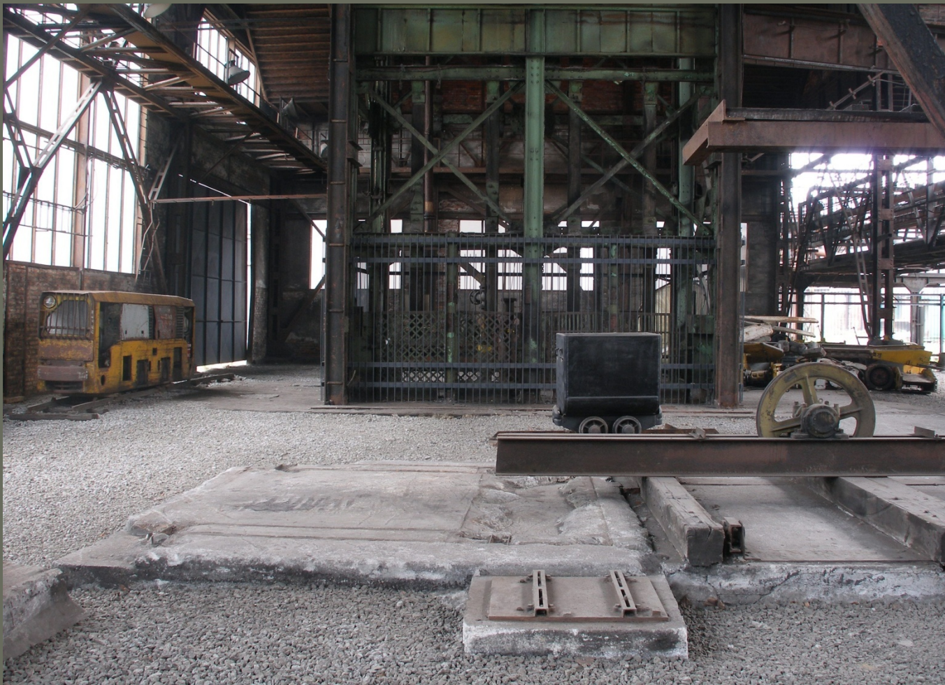
Důl Hlubina, zpřístupnění jámové budovy
